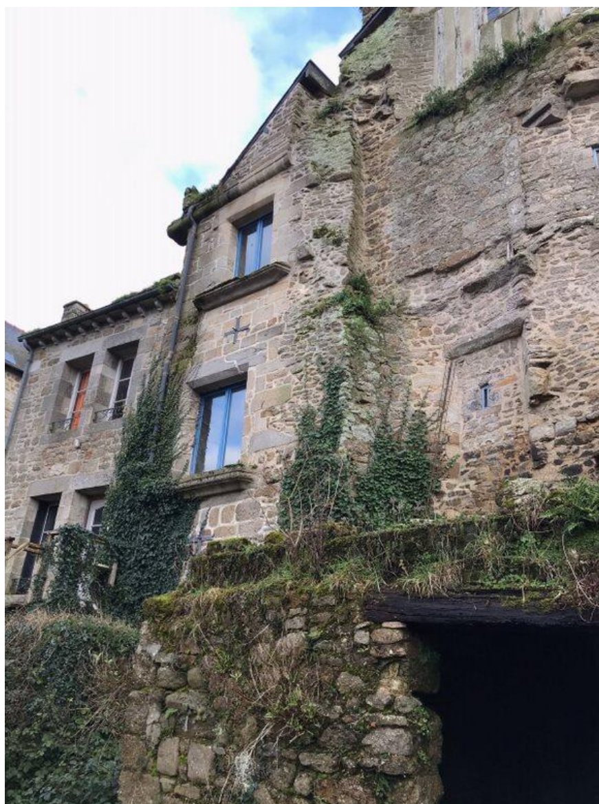
Vue de la façade Nord de l'Hôtel de Clisson (©ER)
